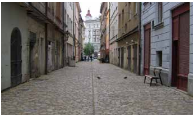
V Kotcích, Staré Město, Praha příklad jednoduchého kladení dlažby v úzké ulici kolmo na fasádu se středovou spárou
