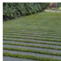
PO_BD2 betonová dlažba se zatravnovací spárou
