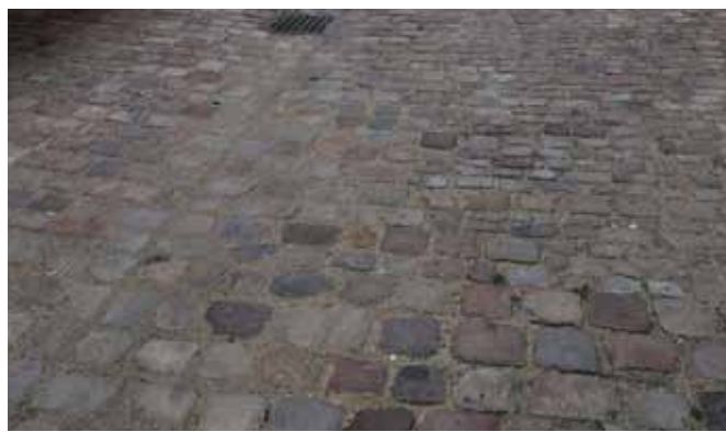
V Kotcích, Staré Město, Praha příklad kladení řádkové dlažby dle pravidla styku tří spár v jednom bodě (vazba na 1/3)
