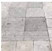
PO_NEV1 žulový hmatný prvek s podélným drážkováním
