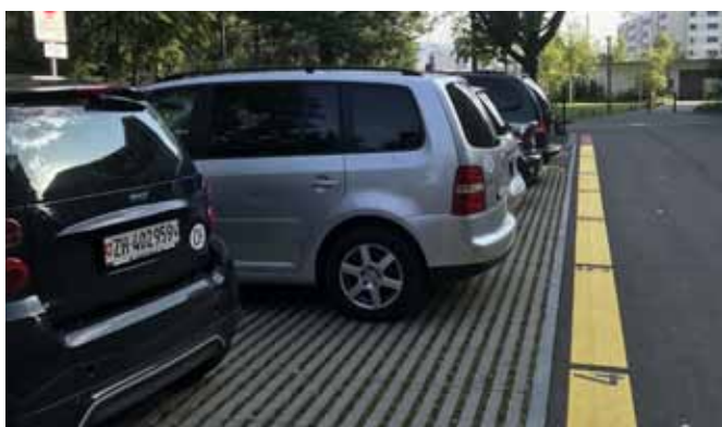
Sihlfeld, Curych, Švýcarsko příklad možného zvyšování propustnosti aplikací zatravnovací dlažby v parkovacích plochách
