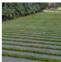
PO_BD2 betonová dlažba se zatravnovací spárou
