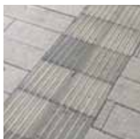
PO_NEV3 betonový hmatný prvek s podél. drážkováním
