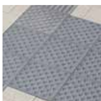
PO_NEV4 betonový hmatný s reliéfní úpravou
