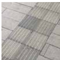
PO_NEV3 betonový hmatný prvek s podél. drážkováním
